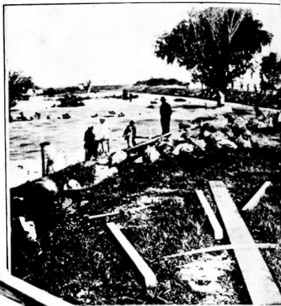
Las aguas del Mississippi, inundadas, cerca de New Orleans, destruyeron de uno de los diques, matando a una familia y a una gran parte de la ciudad.
